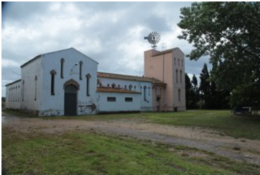
A l'antic escorxador de Calonge, construït el 1912 i catalogat com a bé cultural d'interès local, cohabitaran la comunitat islàmica –a la part blanca– i el casal de joves –a la torre Foto: E.A.
