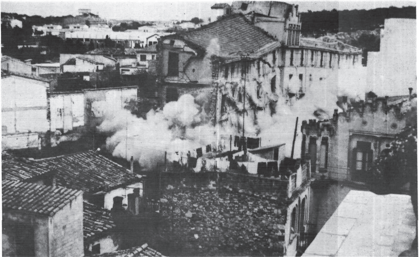
Escena de l'enderrocament de l'antic Balneari Soler, l'any 1975.
