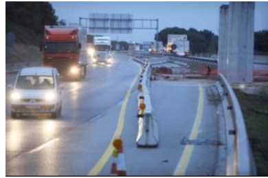
El tram que Acesa està ampliant a l'autopista AP-7, ahir a la tarda. marc marti
