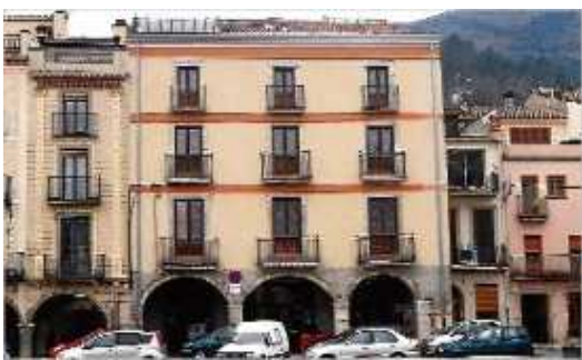
L'edifici està situat a la plaça de la Vila d'Amer.
