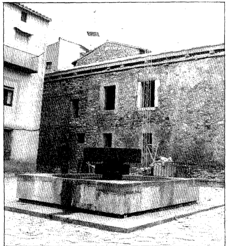
Aspecte parcial de les obres de restauració del Palau de l'Abadia de Sant Joan de les Abadeses. Foto: F.B.
