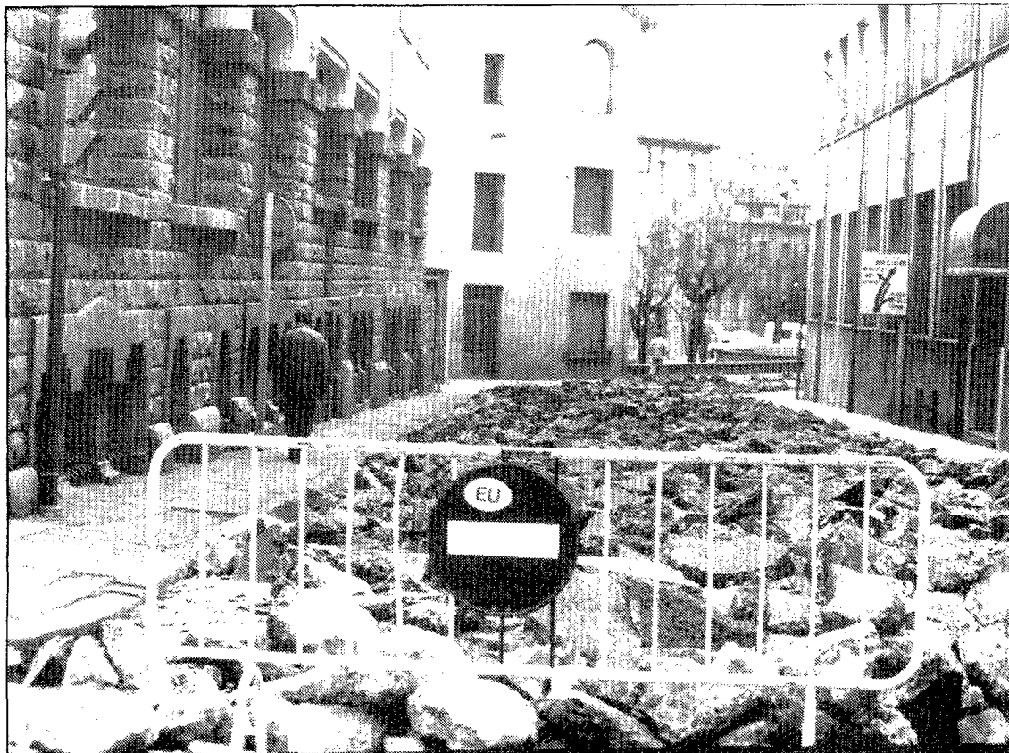
El paviment del carrer Onze de Setembre ja estava totalment arrencat ahir a la tarda. Foto: Fidel Balés.
