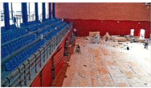
Treballs de col·locació del parquet del pavelló dels Saioners.
