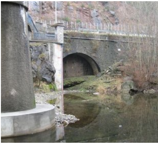
L'estació d'aforament de Ripoll, que s'ha netejat i condicionat Foto: EL PUNT AVUI.
