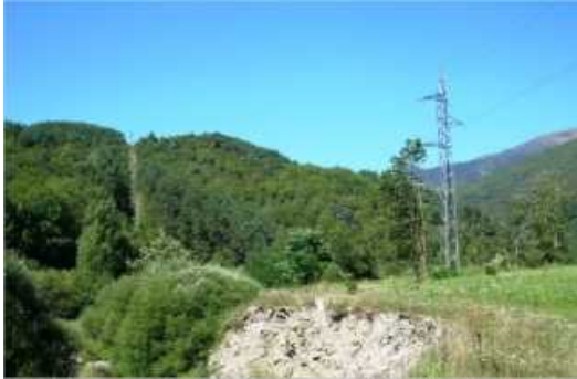
Els treballs de millora de la línia de mitjana tensió, en plena muntanya, ja han finalitzat.
