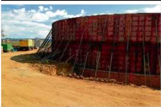
Les obres del dipòsit de 2.000 m3 a Llagostera avancen.
