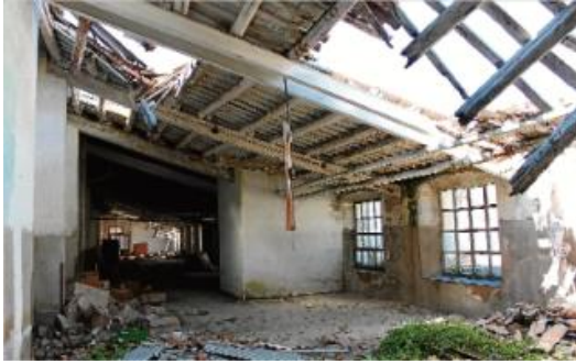
Aspecte de la nau 1, on s'allotjarà el supermercat fent-hi una reforma.
