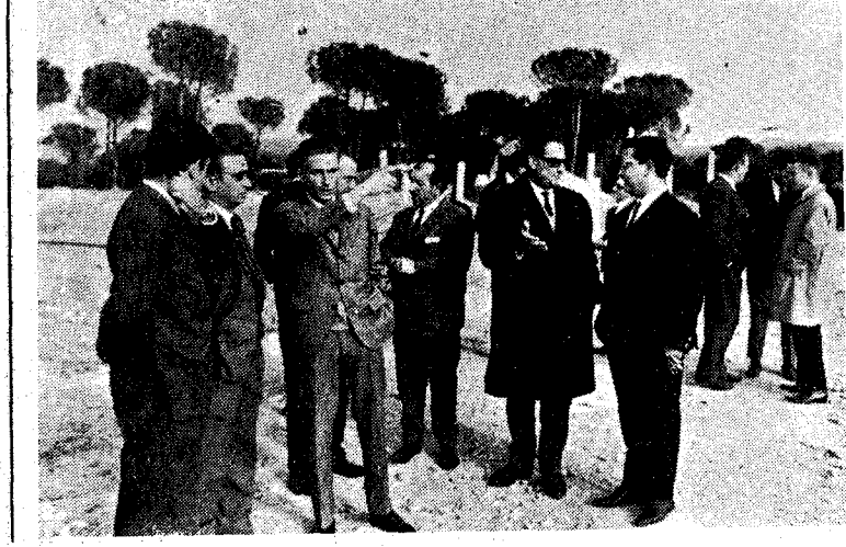
El señor Samaranch, acompañado de las primeras autoridades gerundenses, en las instalaciones en construcción del C.T. Gerona (Foto Pablito)
