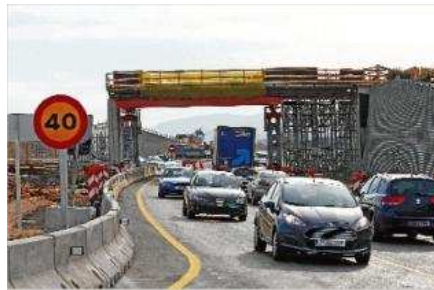
Les estructures per fer el pont per connectar la N-II amb Caldes ja estan fetes a una banda de la via. carles colomer
