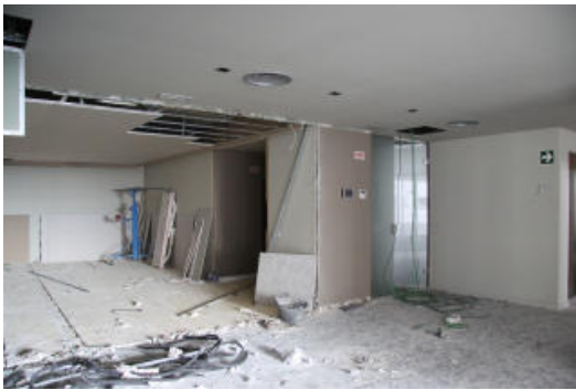
La planta baixa en obres.
