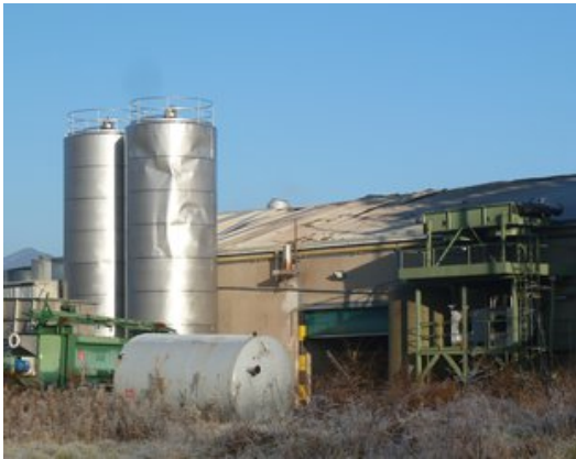
Una vista de la nau on va passar el sinistre amb la porta que va resultar afectada. Foto: J.C.
