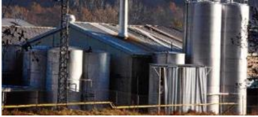
Un home mor en explotar una caldera en una càrnia
