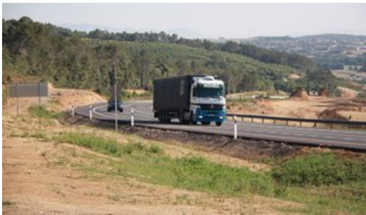
Les obres en el tram Orriols-Vilademuls porten més de tres anys empantanegades Foto: ACN.
