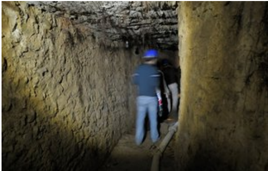
Un dels trams de la mina d'aigua de Torroella que s'han començat a consolidar Foto: J.P.
