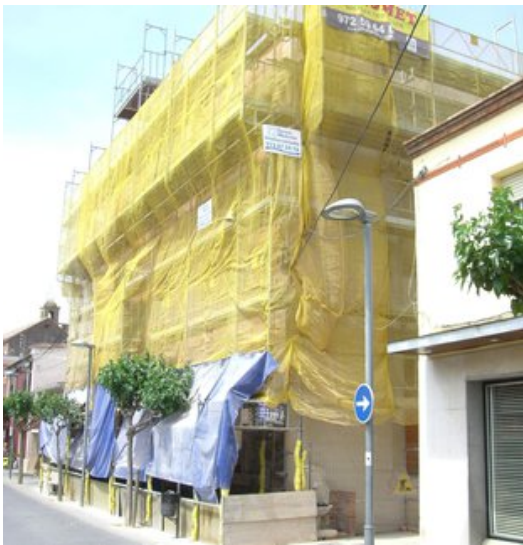
Obres de rehabilitació a l'edifici de l'Ajuntament vell de Vidreres, fa uns mesos Foto: JORDI GONZALO.
