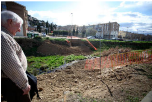
Un veí observa l'inici dels treballs del pont.
