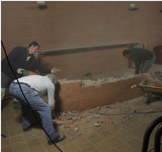
Tres voluntaris treballant per enderrocar l'antiga recepció que hi havia a la sala que s'ha rehabilitat. Foto: EL PUNT.
