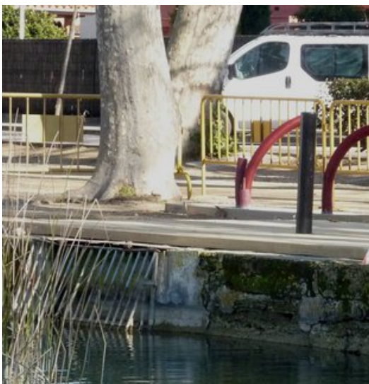
La boca del col·lector situat a prop de l'oficina de turisme de l'estany, encara en obres. Foto: R. E.
