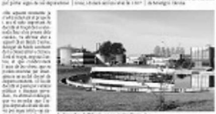
El tanquet de Fortesa, en un moment de la seva construcció.
