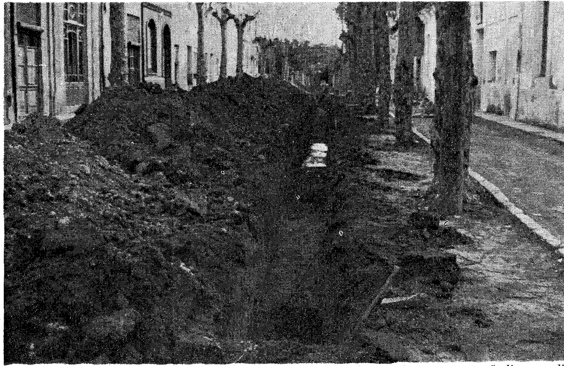
La traída de aguas de esta fiero Oliveras podemos apreciar localidad ya está en marcha. En la foto de nuestro compa-
