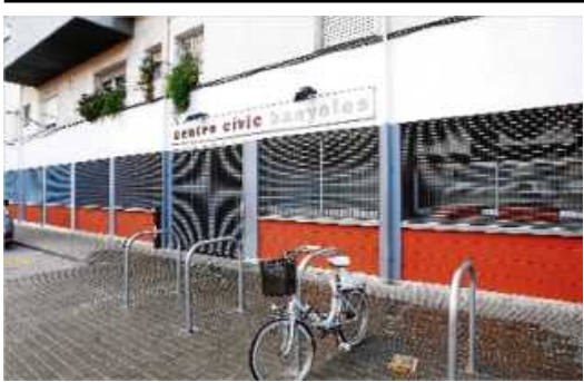
La façana del centre cívic de Banyoles, situat al barri de la Farga, on s'ha reubicat El Boli Blau.
