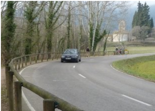
La carretera, a l'entrada de Santa Maria de Porqueres, abans de l'inici de les obres. Foto: R. E.
