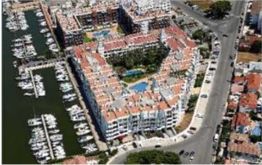
L'edifici del Royal Marine II de Santa Margarida.
