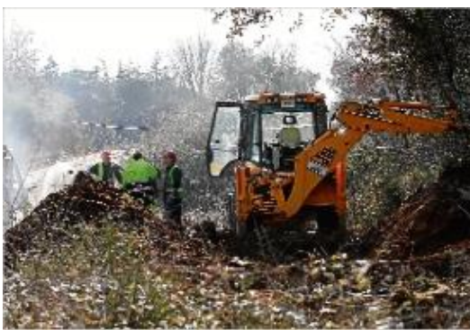
Una de les retroexcavadores va obrir una rasa per contenir el bassal.
