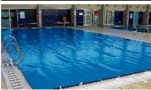
La manta tèrmica de la piscina de Roses que ajuda a l'estalvi.
