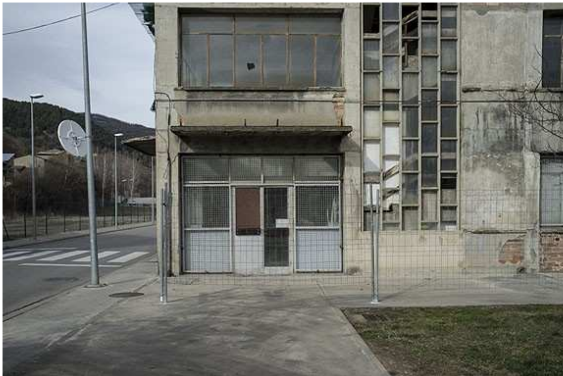
Tanca instal·lada a l'antic edifici d'oficines de Comforsa. Foto: Gerard Garcia i Raül Duque (Rastres)
