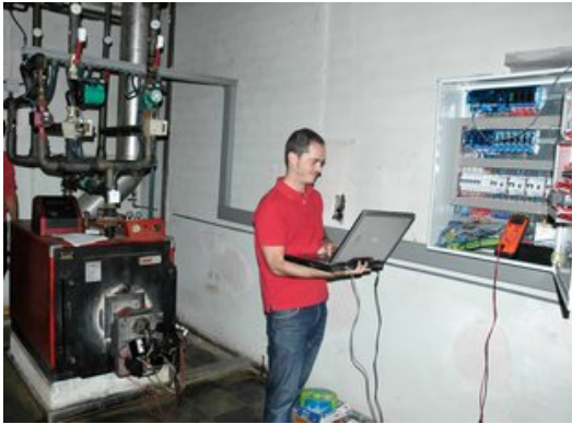
Un operari fa un control del consum de la caldera del convent dels Agustins. Foto: EL PUNT AVUI.
