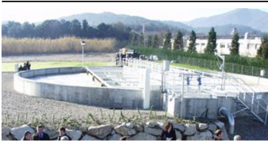
La depuradora d'Anglès, que està pendent d'una reforma estructural urgent. Foto: EL PUNT.
