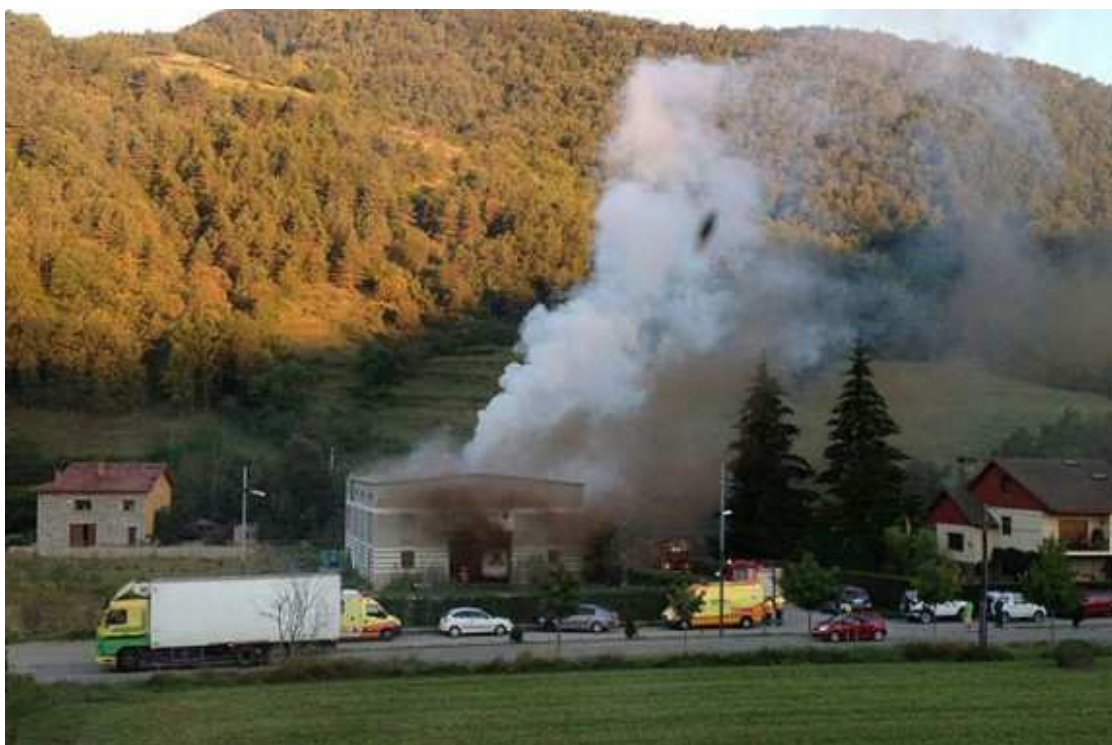
Incendi a la Formatgeria Roura de Sant Pau de Segúries. Foto: Isaac Colomer
