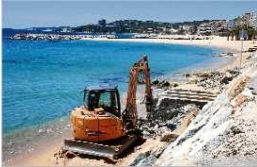
Imatge dels treballs per millorar els accessos a la platja.
