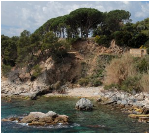
El tram del camí esllavissat a la cala Canyers, on Costes haurà d'instal·lar la passera metàl·lica a la tardor Foto: E.A.
