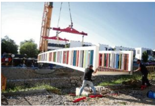
Instal·len, al segon intent, un pont de 19 metres a Roses
