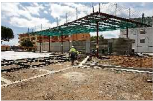
Imatge dels treballs, situat a la travessera cap a l'Estartit.
