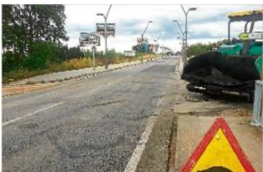
Una màquina aturada ahir en el tram en obres.
