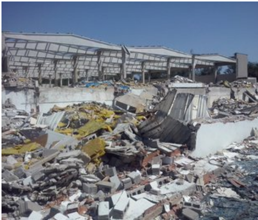
Una imatge d'ahir del mal estat de l'edifici, on hi ha piles de runa amuntegada, que els lladres segueixen buidant Foto: G.P.
