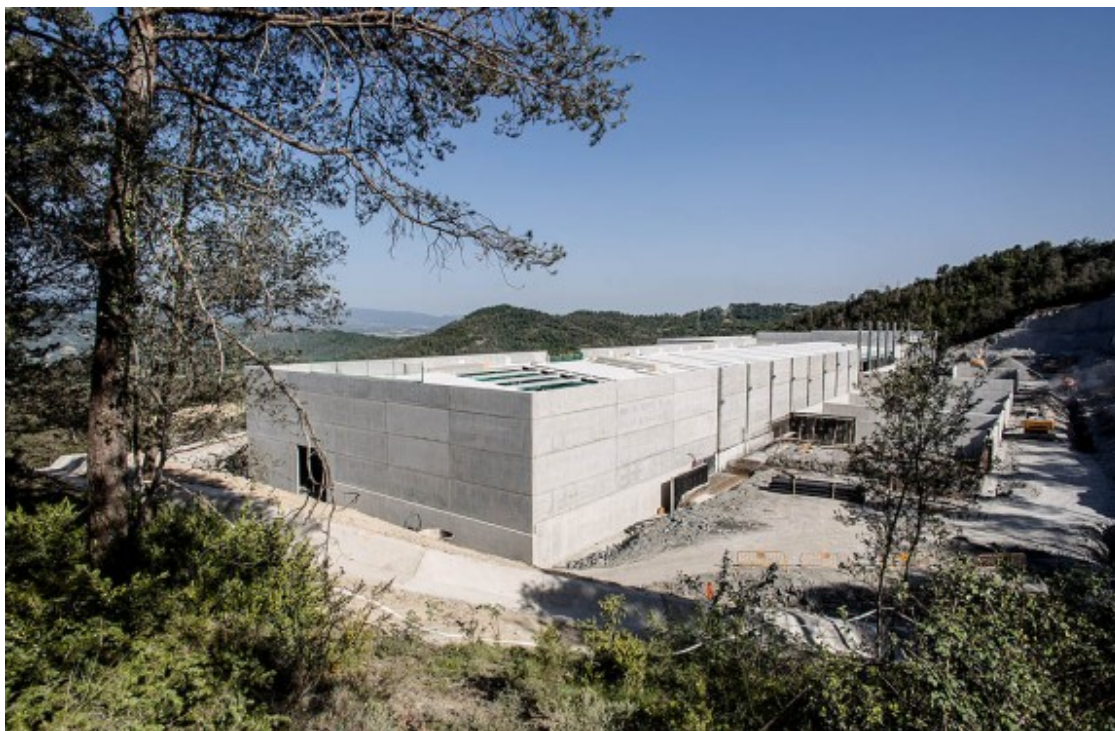
Les obres del nou Centre de Tractament de Residus, aquest divendres. Foto: Adrià Costa
