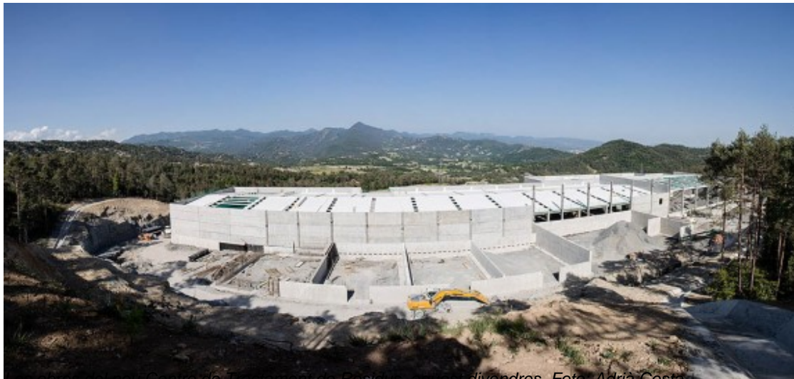
Les obres del nou Centre de Tractament de Residus, aquest divendres. Foto: Adrià Costa
