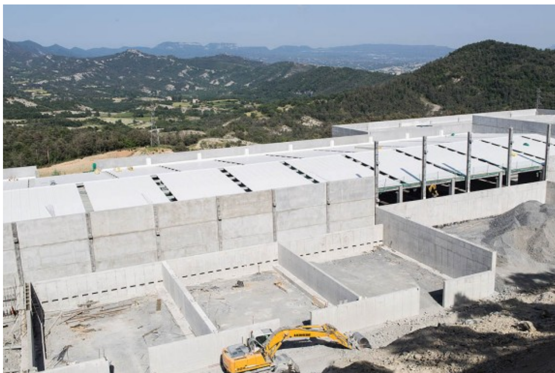
Les obres del nou Centre de Tractament de Residus d'Osona i del Ripollès. Foto: Adrià Costa
