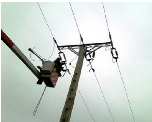
Treballadors d'Endesa, en els treballs de reforçament de les línies elèctriques de mitjana tensió. Foto: EL PUNT AVUI.
