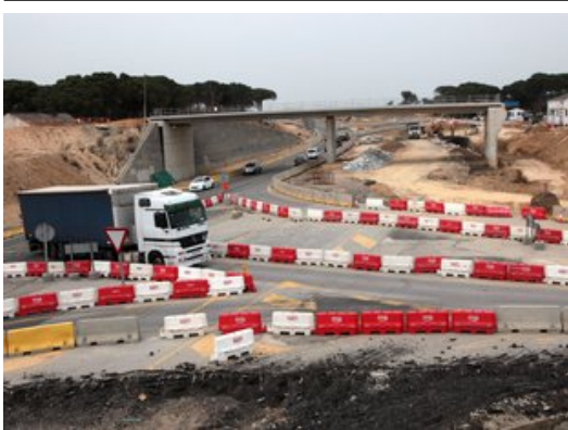
Les obres de l'enllaç de Caldes van començar al novembre. La foto és del març. Foto: J. SABATER.
