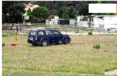
Una imatge dels primers treballs als terrenys de la futura escola. carles colomer
