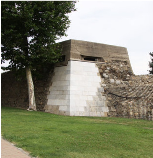
Un dels angles de la ciutadella on s'ha actuat per recuperar els carreus que havien desaparegut Foto: EL PUNT AVUI.
