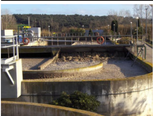
Detall de la depuradora de la Bisbal d'Empordà Foto: ACA.
