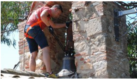
Un operari durant l'acte d'instal·lació de la campana en el campanar. Foto: EL PUNT AVUI.
