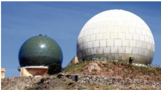
Les dues boles instal·lades de forma provisional a la base aèria del Pení de Roses.
