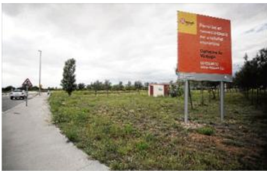
L'estat actual de la zona industrial amb els carrers urbanitzats però aturada des de fa anys.
