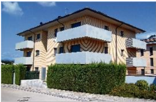
El bloc de pisos on es troben els habitatges de lloguer.
