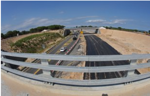
Visió des del gran rotatori elevat que s'està construint a l'enllaç amb Caldes Foto: LLUÍS SERRAT.
